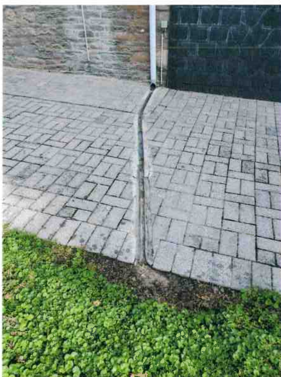
Photo du caniveau qui évacue les eaux pluviales de la toiture principale.
